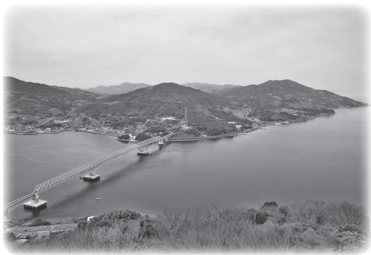
大島大橋（周防大島町）
